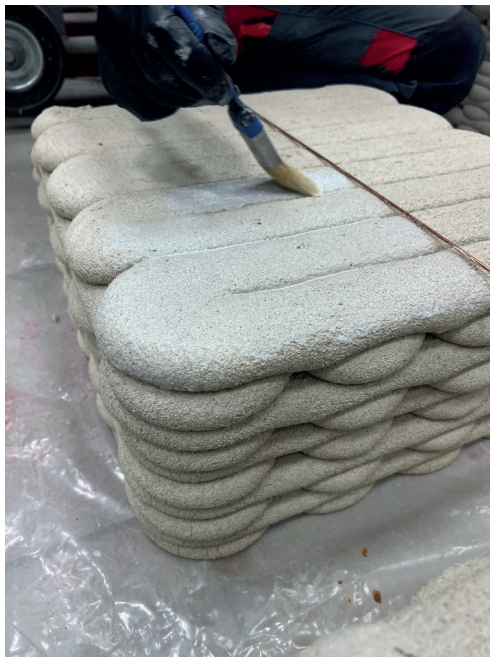
a) applying primer
